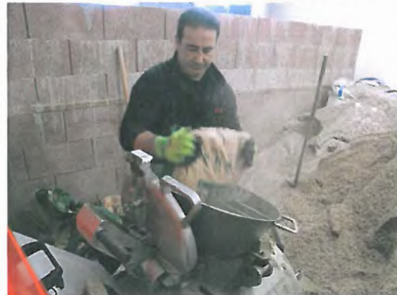
Bild 4: Einfüllen des Zements für die Standardestrichmischung
